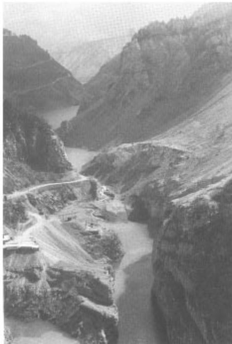
**Figura 3** - La frana avvenuta nel 1961, già incisa dal flusso idrico, divide in due il lago il cui livello è stato abbassato da 650 a 600m
